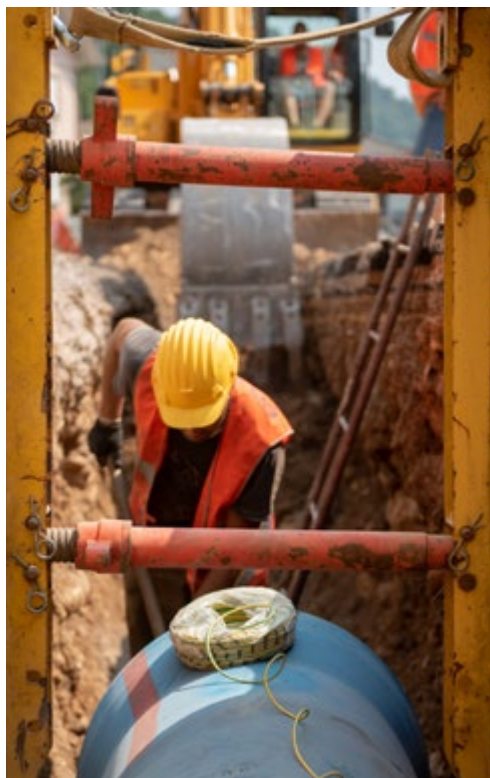
Viacqua / Cantiere PFAS a Valdagno (Vicenza)
